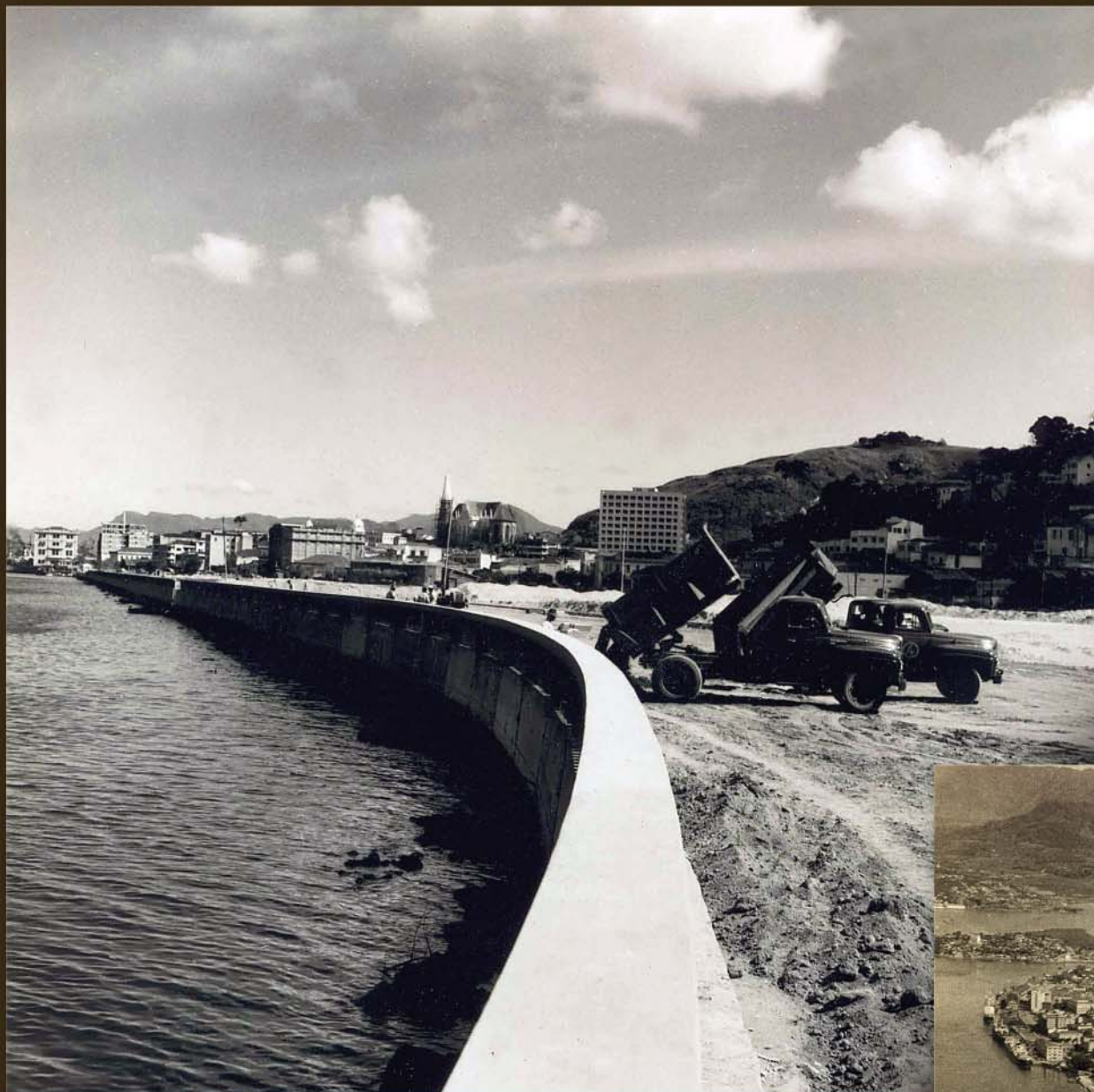
Execução do aterro da Esplanada Capixaba. No centro, ao fundo, o Ed. Presidente Vargas em construção (Acervo do Arquivo Geral da PMV).
