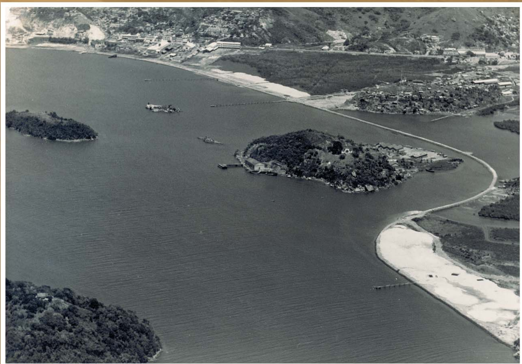
O enrocamento e o começo do aterro. Vêem-se a ilha da Fumaça e a ilha de Monte Belo. É possível identificar a imensa área conquistada ao mar entre a Av. Vitória e o limite do enrocamento ( Acervo da Cultural ).
