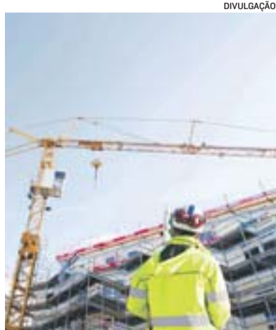
TRABALHO na construção civil
