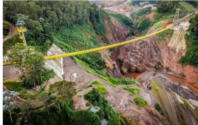
2ª PONTE DO TC411 (2018) em Mariana/MG vão: 302 m torres: 30 m
